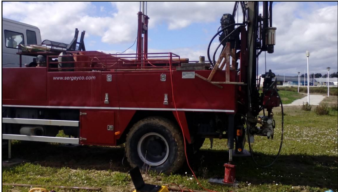
Fotografía 2.1 Vista del equipo utilizado Deep Drill
